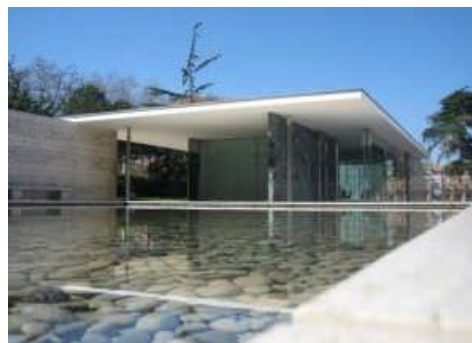
4B. L. Mies van der Rohe: Pabellón de Alemania . 1929.
